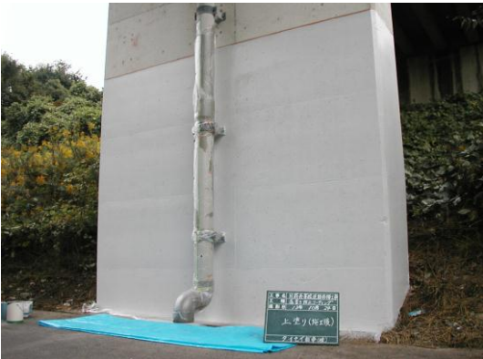
橋脚 汚れ、落書き防止
