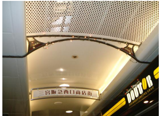
アーケード内装 美装仕上げ
