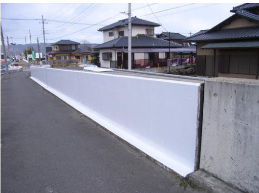
道路側壁 汚れ防止
