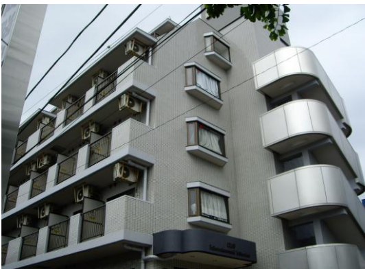
外壁タイル 汚れ防止
