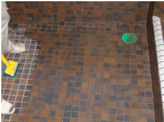
浴槽タイル 汚れ、劣化防止
