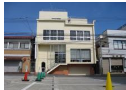
施工後(青森県住宅)
