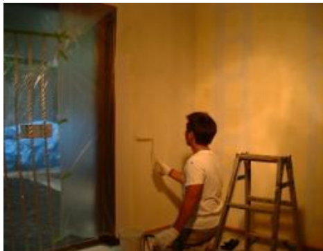
施工中(神奈川県宿泊施設)
