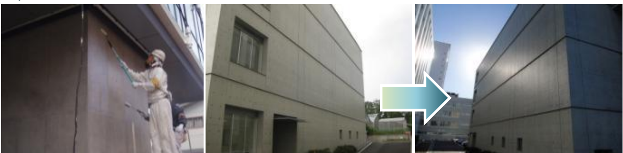
施工中(東京都研究施設)
