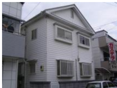
施工後(長崎県住宅)
