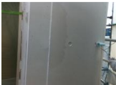
施工中(東京都マンション)
